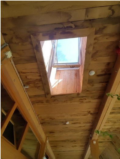
Dachöffnung, EuroSolar-Foto [E, S. 8].
